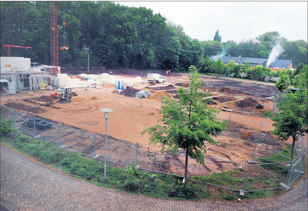
Wohnen am Simeonscarré: Hier entstehen in den nächsten Monaten 17 Reihenhäuser sowie ein Mehrfamilienhaus mit altersgerechten Wohnungen. MT-Foto: Manfred Otto
